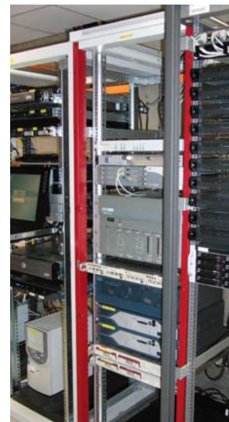
Detall de la plataforma MediaCAT del Campus de la Mediterrània de Castelldefels.
